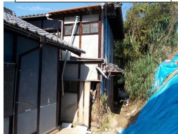
斜面崩壊・被災状況（H30年7月）
